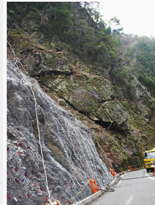
写真-1 吹付工施工前
